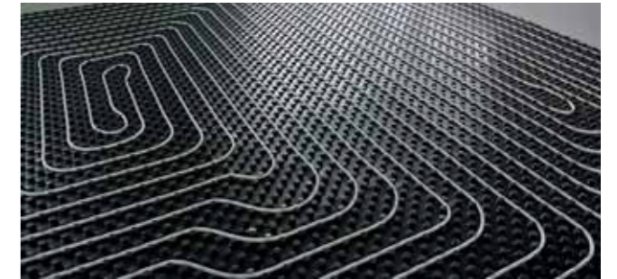
Rys. nr 9: Przewody rurowe do ogrzewania podłogowego
